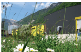
Installation de méthanisation et compostage, Villeneuve
