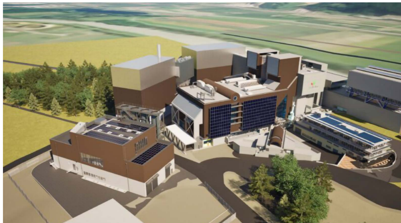
INOSAT sera composé de deux nouveaux bâtiments (en arrière-plan)
